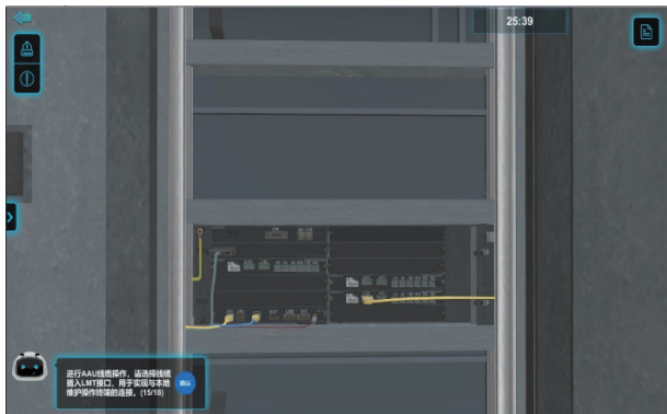
图 6 基站安装完成图
