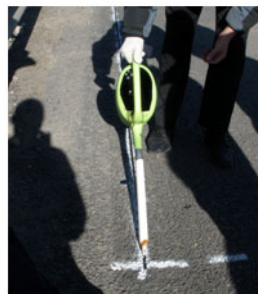
Pouring the epoxy
