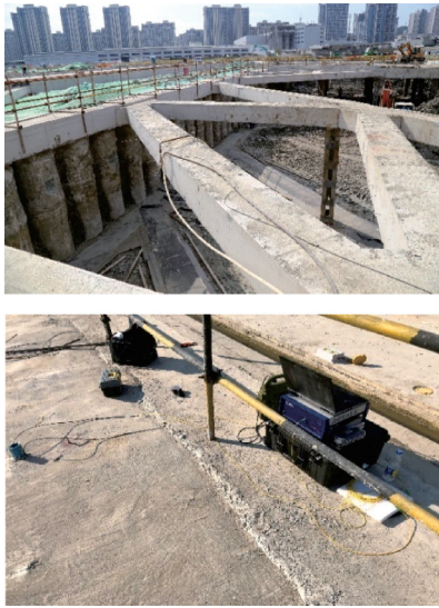
图 12 基坑开挖现场
