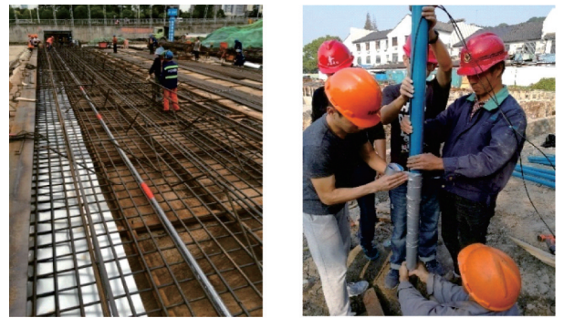
(a) 光纤传感器安装在地连墙钢筋笼 (b) 向测斜孔内下放光纤传感器
