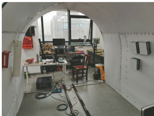
图 4 模拟隧道实物图
