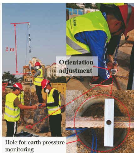
图 10 FBG 土压力传感器的安装示意图
