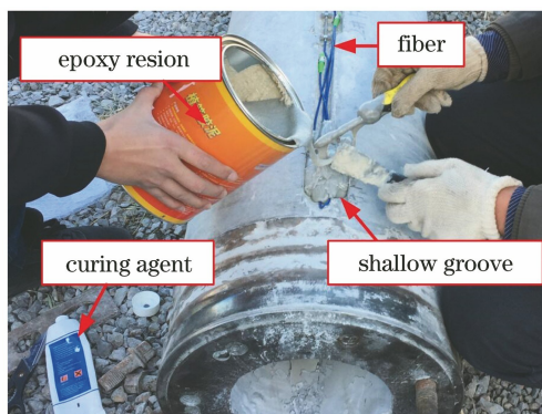
图 8 环氧树脂填充于浅槽
