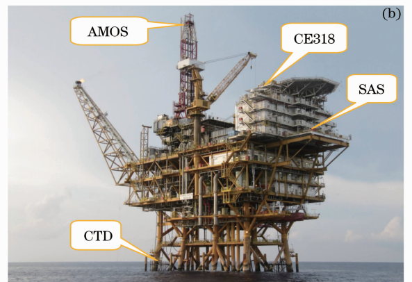
图 1 (a)南海 PY30-1 平台站点与(b)观测仪器安装位置
