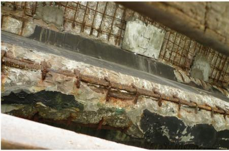
图2 钢筋混凝土结构的损坏
