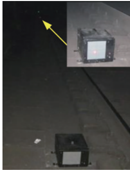
图 9 路基表面沉降监测系统现场安装图
