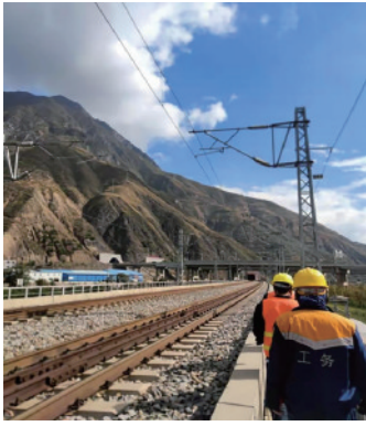
图 5 隧道现场工况图
