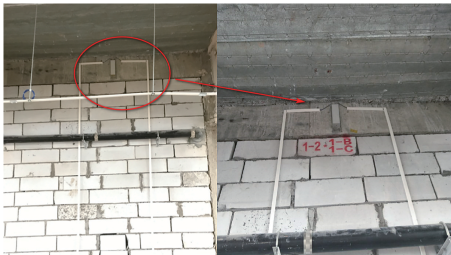
图 13 倾斜传感器现场安装效果图
