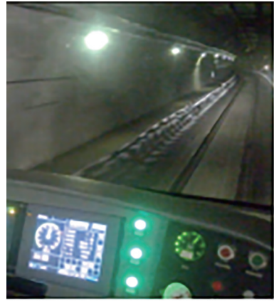
图 4 列车快速运行中的地铁隧道场景 Fig. 4 Subway tunnel scenario with fast train running
