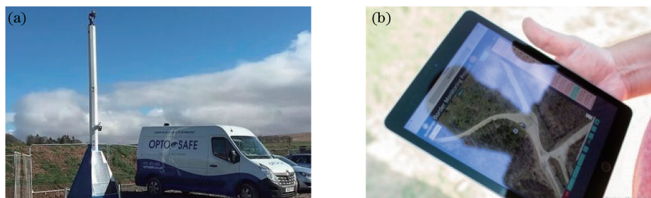
图 18 安防系统设备图 [50] 。(a) Optosafe Opto-Q-Guard 系统；(b)电子设备监控
