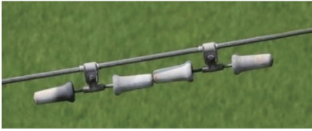
图3 防振锤滑移示意图
