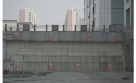
图 9 在被测对象上用于精度检查的编码目标
