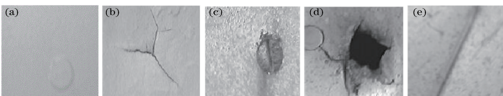
图 11 飞机蒙皮表面的损伤情况。(a) 正常蒙皮; (b) 裂纹; (c) 腐蚀; (d) 撞击; (e) 划痕
