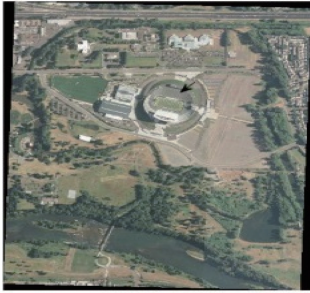
图3 测区航拍体育馆影像图
