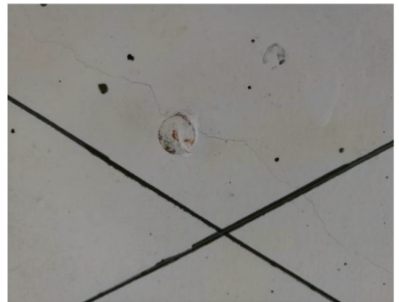
图6 斜裂缝
