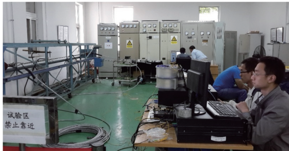
图 17 该传感系统用于高压输电线电缆覆冰检测
