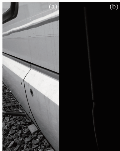
图 8 现场实验图片。(a)动车组侧面图;(b)测量特征图像
