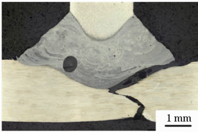
图 15 T 型接头横向拉伸断裂形式
