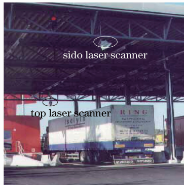
图 3 车厢体积计算系统现场安装图
