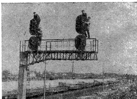
图 2 三结合小组成员在现场安装调整好的信号色灯
